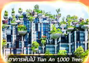
อาคารพินันที Tian An 1,000 Trees
